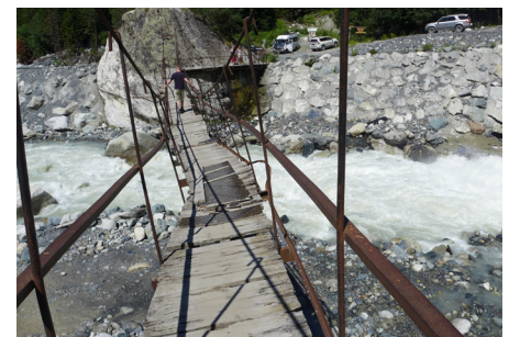
Hængebroen der udgør starten på vandrouten til Chalaadi gletcheren. Man går over den med meget forsigtige skridt.
